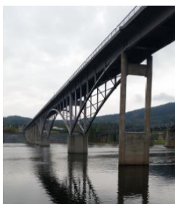
NAS har foretatt inspeksjon av flere hundre bruer siden 2015.
