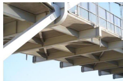
NAS har de tekniske og menneskelige ferdighetene for å foreta en helhetlig 360° bruinspeksjon.
